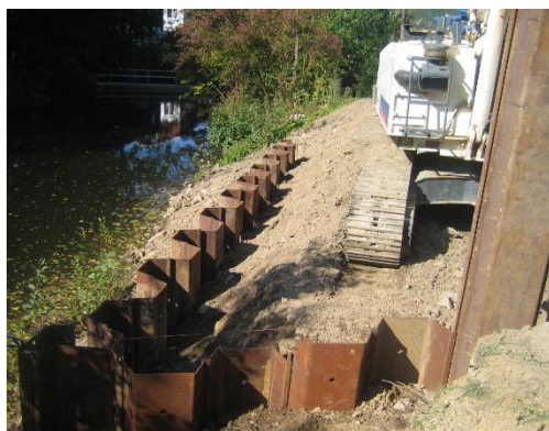
Neubau einer Straßenbrücke über die Bigge im Zuge der Westumgehung
