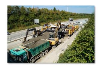
Im Auftrag der Autobahndirektion Nordbayern erneuerte Max Bögl die Betonfahrbahn und sanierte die Entwässerung auf einem rund zehn Kilometer langen Autobahnabschnitt auf der BAB A7 zwischen den Anschlussstellen Gollhofen und Uffenheim.
