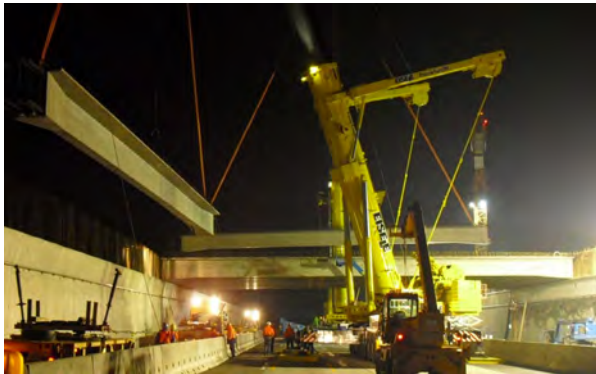
Bild 22: Nachtbaustelle und Einhub der Brückenträger
