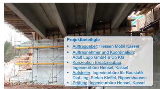
Bild 7: Betonverbundbrücke im Bauzustand
