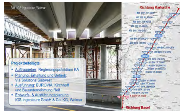
Bild 16: Serielle Ersatzneubauten entlang der BAB A5
