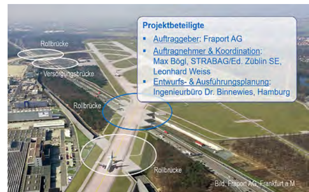
Bild 19: Übersicht Rollbrücken Flughafen Frankfurt
